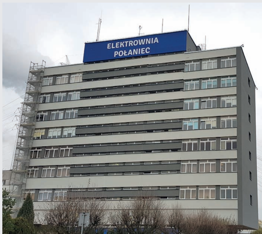
Budynek biurowca F-12 po termomodernizacji
